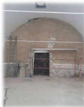
Mur de la chapelle St Roch
